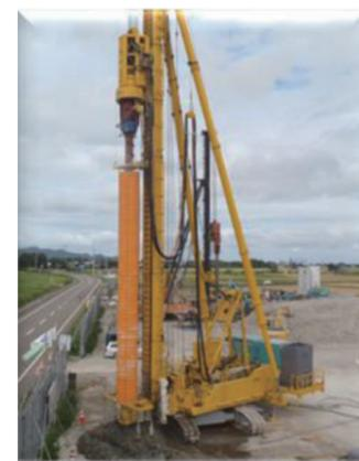
写真-1 深層混合処理工法施工機
