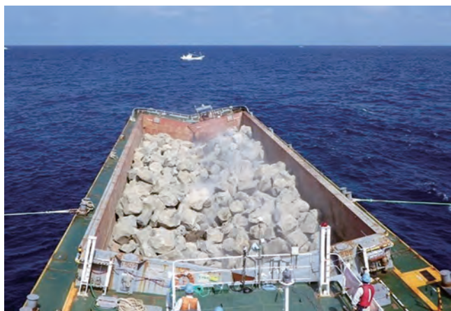
写真-1 石材投入状況
