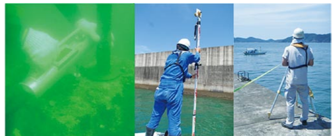
写真-1 水中スタッフおよび水中水準測量器による計測状況
