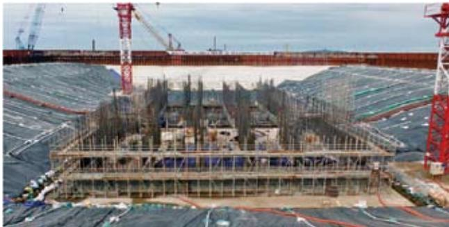
写真-3 海水取水ポンプ場の施工状況
