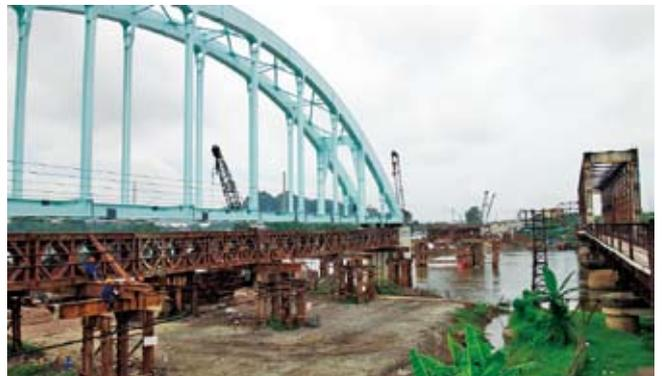
写真-2 橋梁区間タイドアーチ橋施工状況
