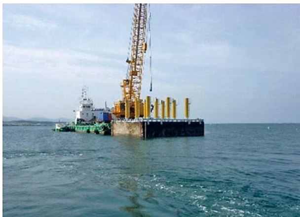
写真-7 ケーソン曳航状況
