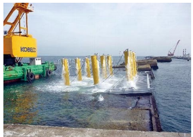
写真-6 ケーソン排水・浮上状況
