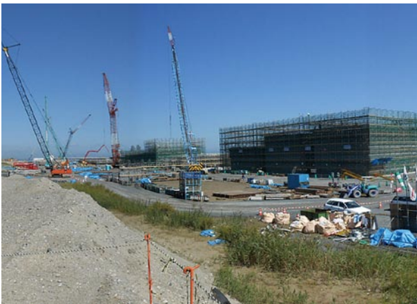
写真-5 ケーソン製作状況
