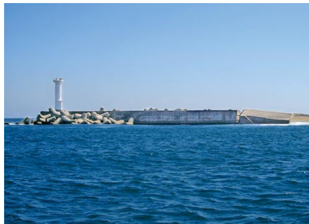
写真-8 損傷が比較的小さかった堤頭函
