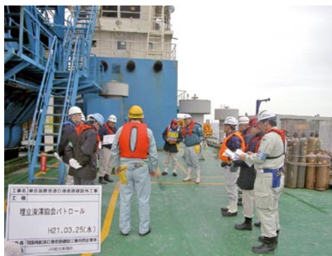
東京国際空港 D滑走路外建設工事の安全パトロールの様子
