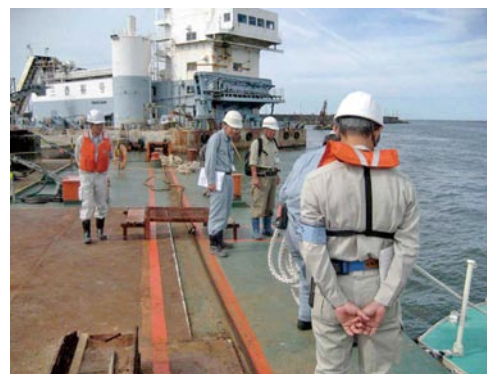
新潟港 H20 西港地区第二防波堤築造工事の安全パトロールの様子
