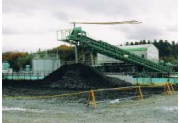
写真-2 機械脱水後の状態
