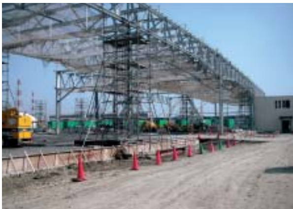
写真3-2 名古屋港東浜緑地コンバージョン事業
