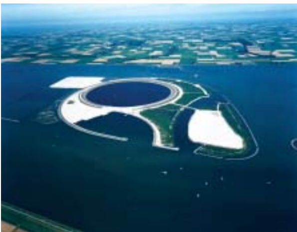
写真-2.1.1 アイセログ処分場全景 1)
