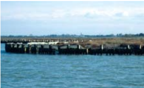
写真-2.2.2 木柵の状況
