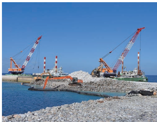
護岸築造工事の様子
