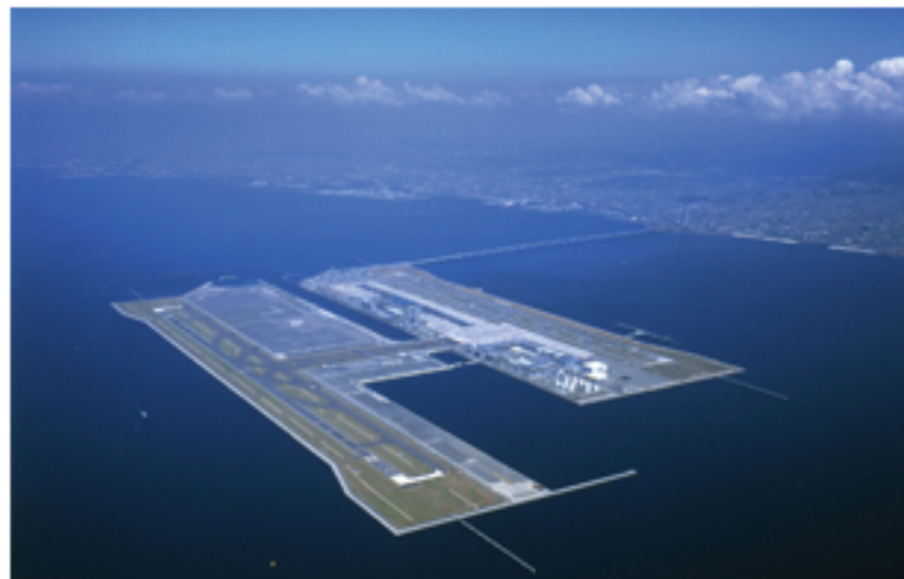
大阪湾の沖合5kmの海上につくられた関西国際空港 写真:関西国際空港用地造成株式会社
