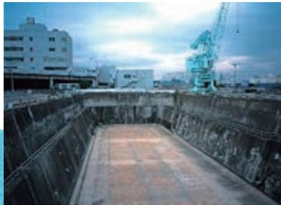
これが「ドライドック」。ここでコンクリートの箱を作って、完成したらドライドックに海水を入れて箱を浮かして海に引出します。
