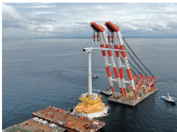
福島県沖での浮体式洋上風力発電システムの実証研究事業 (5MW 風車解体状況)
