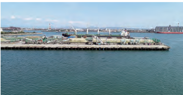
改良工事中の衣浦港中央ふ頭西地区岸壁
