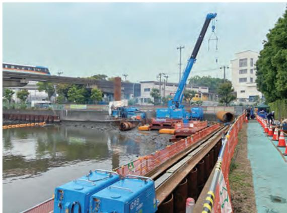
クランプクレーンを使った鋼管杭の打設作業
