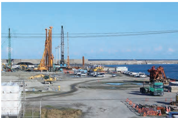
鹿島港外港地区で進む地盤改良工事
