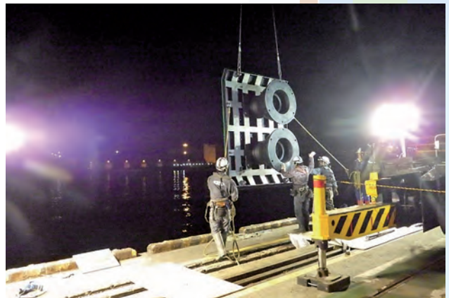
夜間での防舷材設置状況
