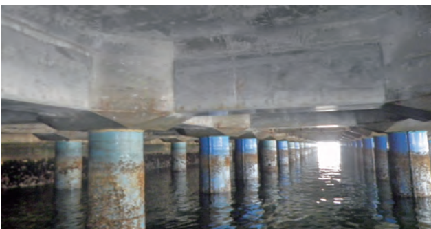
劣化した杭と梁の改良工事を終えた岸壁
