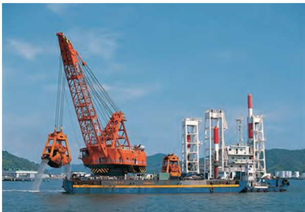
浚渫作業中の第三十六龍王丸
