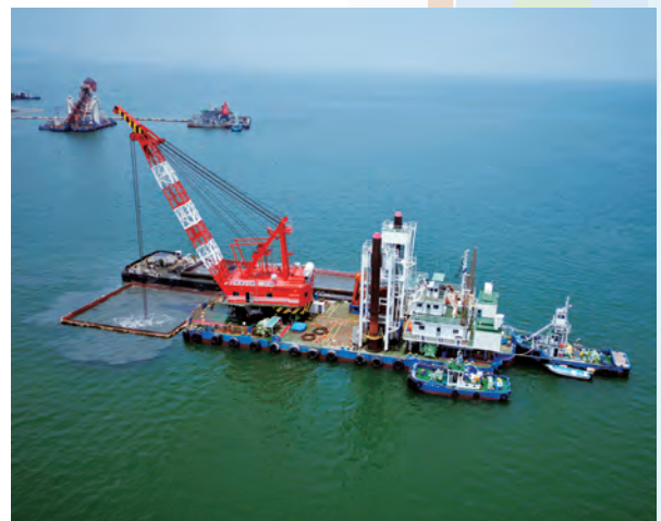
浚渫作業中の鷺羽号
