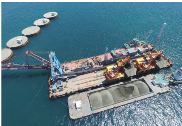
鋼管セルへの中詰め作業で稼働する「AOKI MAR 2001」
