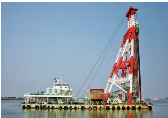
サンド・コンパクション・パイル船「第80光号」
