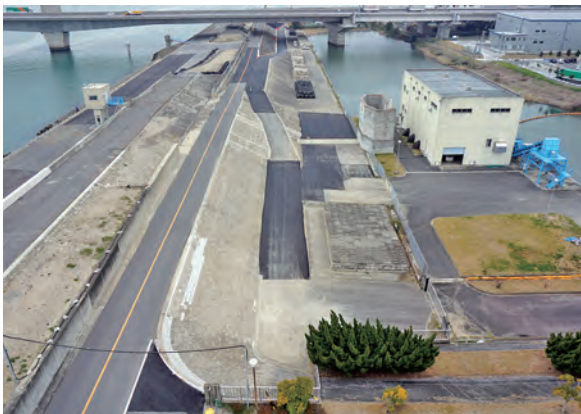
揖斐川城南上流川裏高潮堤防補強工事の完成写真
