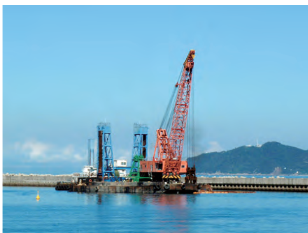
泊地の浚渫工事の様子。
