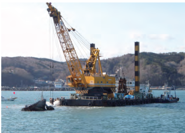
久慈港で被災ケーソンを取り壊す「真洋」
