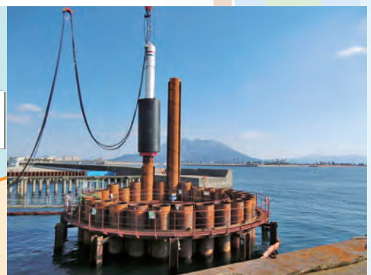
鋼管矢板の打設状況。後方には桜島が見える。
