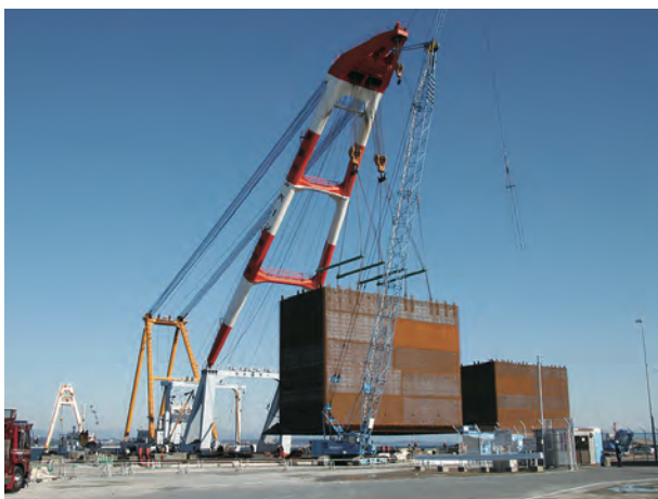
ハイブリッド構造のケーソンが御前崎港の製作ヤードに3月10日に設置された。
