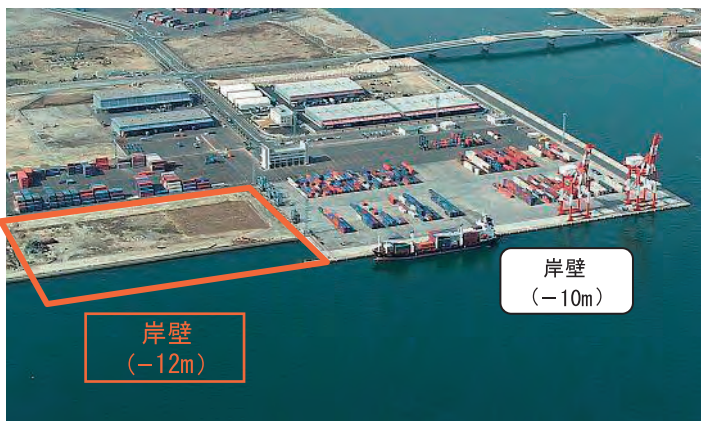
水島港玉島地区岸壁（-12m）（耐震）工事の現場
