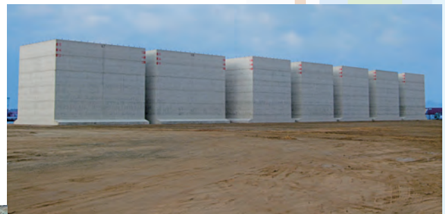
製作を終了したケーソン
