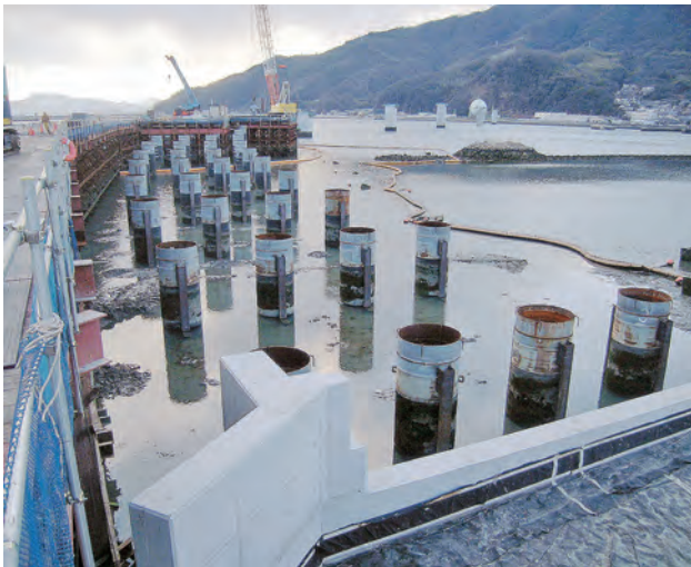
潮位差が3.7mある建設現場
