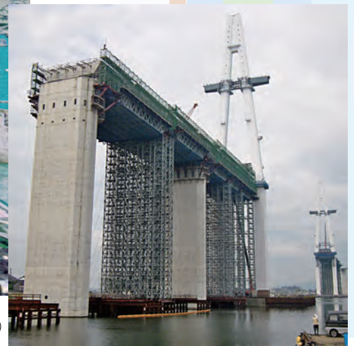
橋梁部の側径間工事現場
