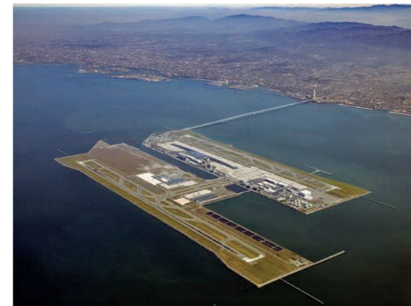
関西国際空港2期工事
