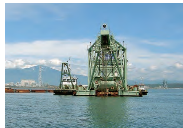
酒田港の航路浚渫工事(1990年代に撮影)。後方に鳥海山が見える
