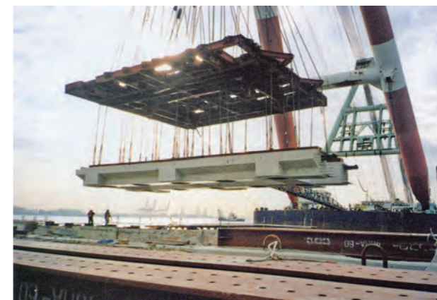
南側での上部工PCaブロックの据付作業
