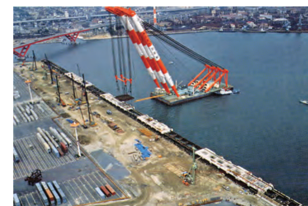
東側での上部工PCaブロックの据付作業
