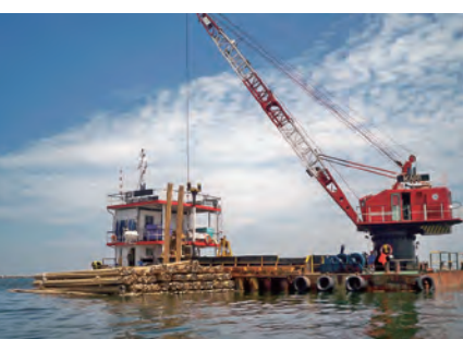
タンジュンプリオク港での竹杭の施工状況
