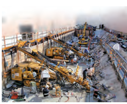
構内の地盤を掘り下げた削孔作業
