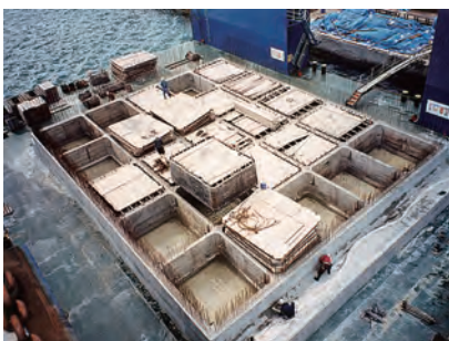
製作中のケーソン
