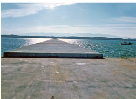
完成した外周護岸の一部
