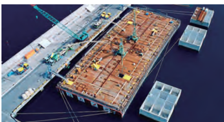
すくい上げ方式による鋼殻の積み込み作業① と回航後の高流動コンクリート浮遊打設状況②
