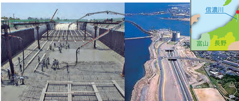
擁壁部工事の様子②と完成した道路の全景
