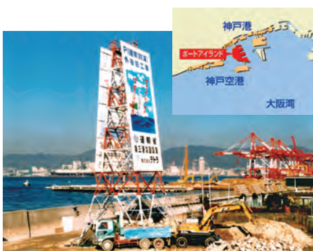
ポートアイランドの護岸復旧現場
