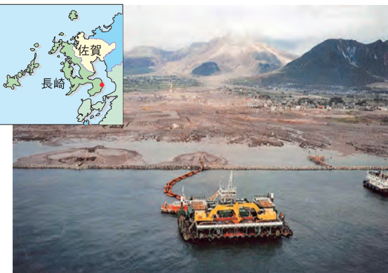
水無川河口部で実施した護岸築造の様子
