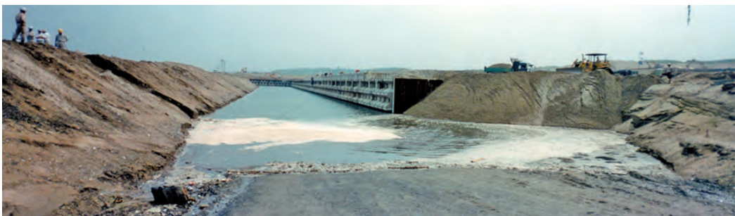
仮締め切り部を切って海水を入れた様子。右側の構造物が岸壁となる部分。
