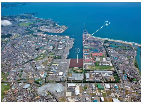
東日本大震災前の仙台塩釜港仙台港区。①が航路陸上掘削工事の場所、②がケーソンヤード床掘及び海上打継場築造工事の場所。 提供：塩釜港湾・空港整備事務所
