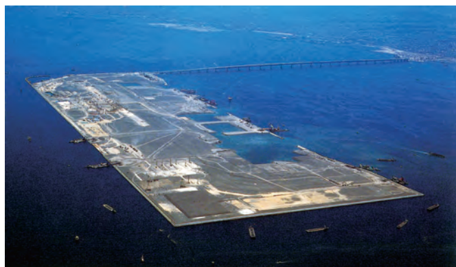
造成工事中的の関西国際空港
