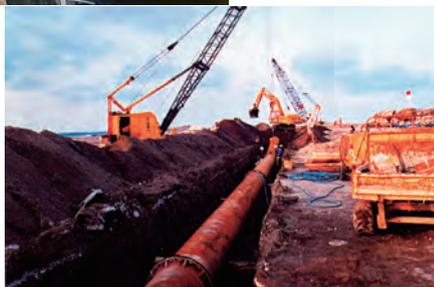
排砂管の摩耗を独自に推測し、河床に敷設する海底管(鉄管)の厚みを通常の倍の16mm、それを3列敷設することにしました。最後はポンプ浚渫船に長年携わった経験で判断したとしか言いようがありません。」
