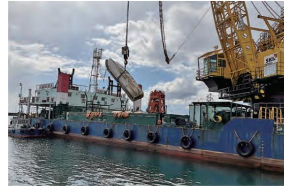
【左上写真】輪島港 地盤隆起により水深が浅くなった漁船だまりで漁船が移動できるよう浚渫を行っている様子（6月30日撮影）
