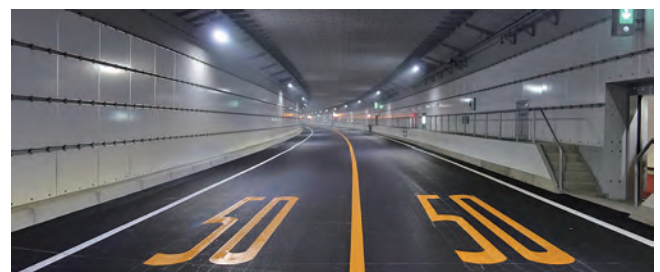
トンネル完成
