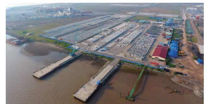
ブロックの製作ヤード
