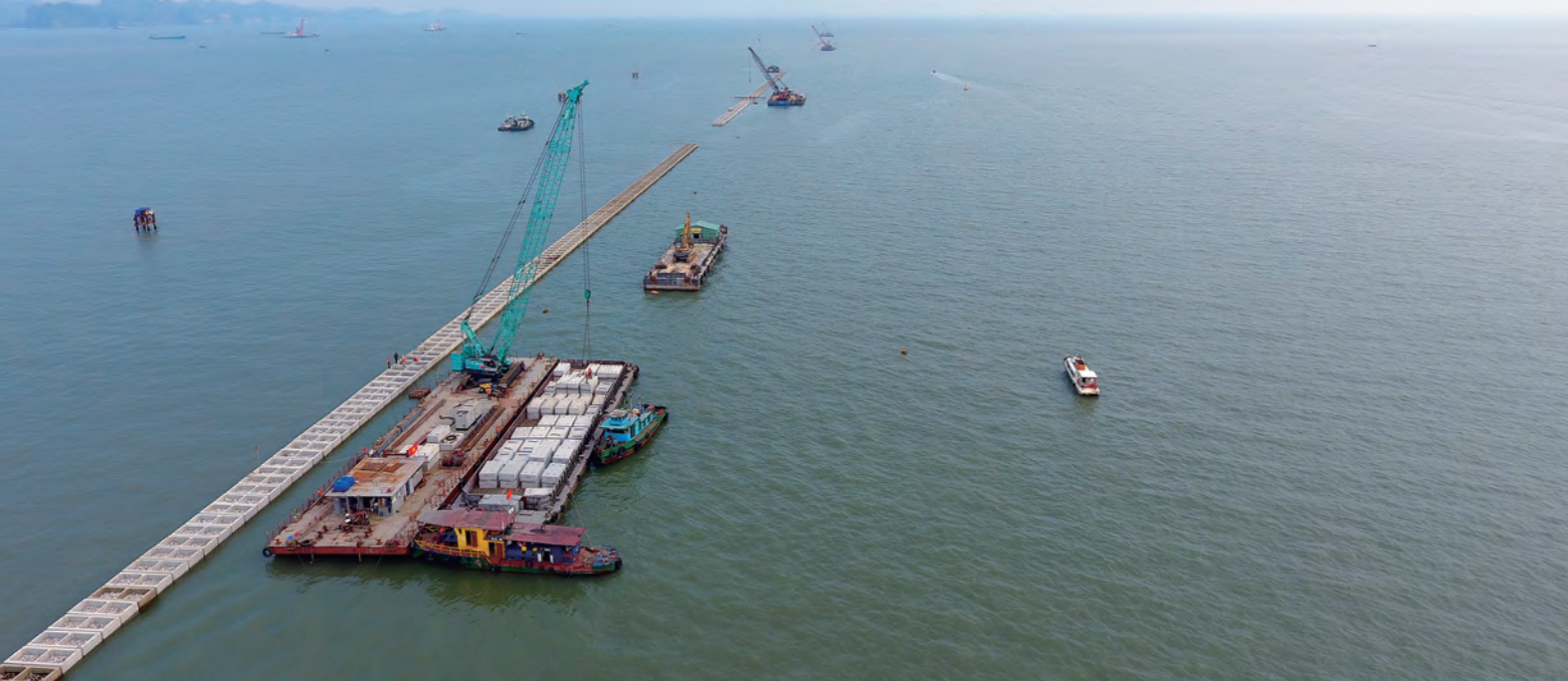
広大な海域で進むラックフェン国際港の工事
