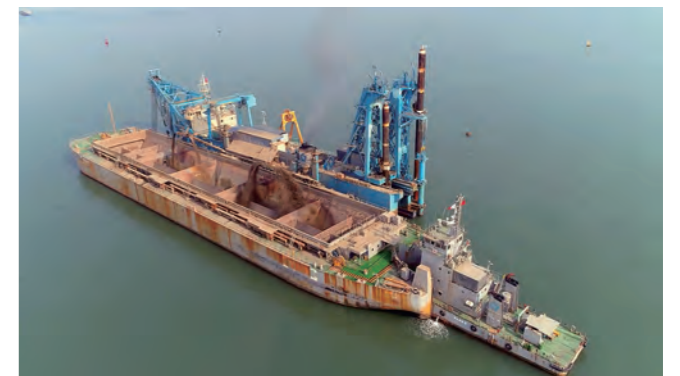
航路の浚渫工事④⑤
