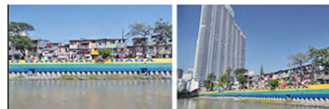
写真-8 河川改修完成
