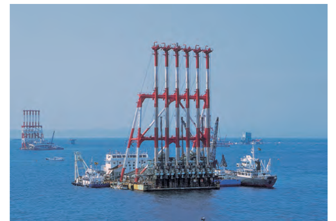
サンドドレーン(SD)船による地盤改良工事
